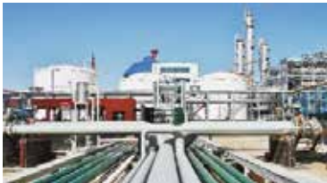
管线周边施工情况
