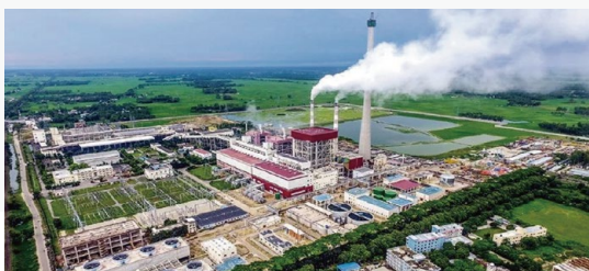
孟加拉艾萨拉姆 2x660MW 燃煤电站
